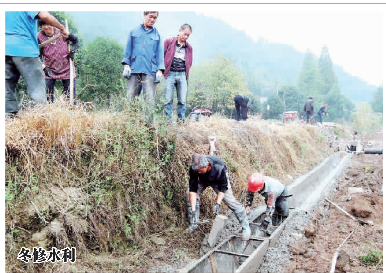
冬修水利 记者 李建林 通讯员 舒清海 文/摄 利新高潮。 据了解,经过镇村干部和村民的共同努力,泉溪镇目前已完成投资900万元的农田节水灌溉工程,投资1400万元的万亩高标准农田建设项目完成工程量的50%,两座险水库的整修有序推进,投资3500万元的武义江南岸机宅至麻蓬段防工程已经完成工程量的80%。
